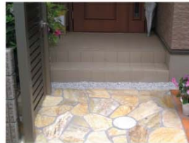
ポーチの可動部処理
