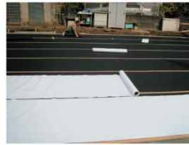
下部すべり材敷設
