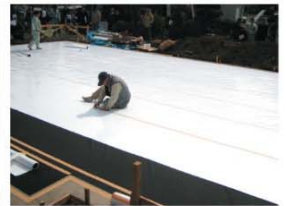
目地フッ素樹脂テープ固定
