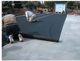
防水シート敷設
