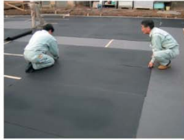
保護ゴムマット敷設
