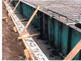
立上がり型枠固定
