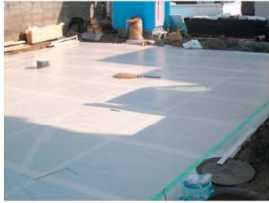
上部すべり材敷設
