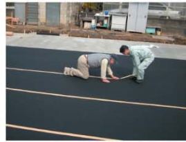
目地粘着テープ固定
