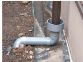
雨水管設置状況
